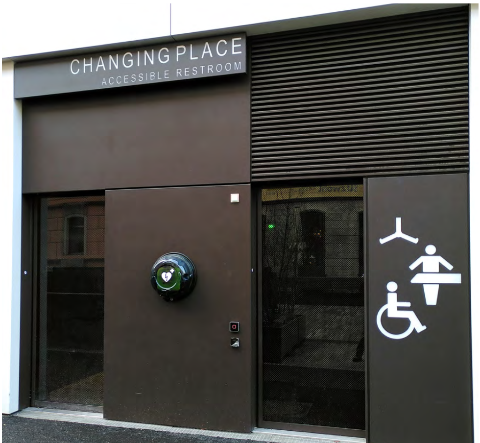
Der neue Changing Place (Accessible Restroom) in der Gilmstraße in Innsbruck
