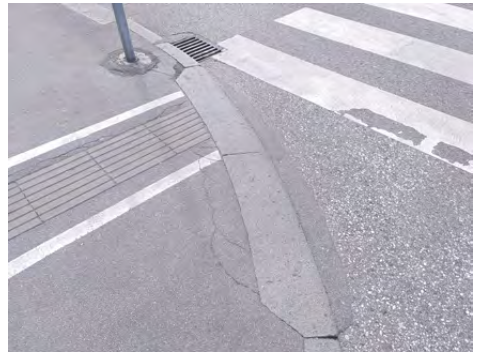
Abgeflachte Gehsteig-Kante bei einem Zebra-Streifen
